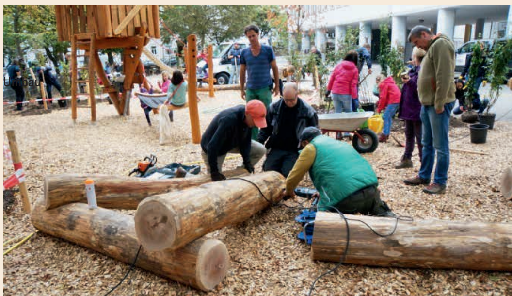
Entsiegelung und Bau des Atriums (oben) und Zusammenfügen des Baumstamm-Mikados (unten)
