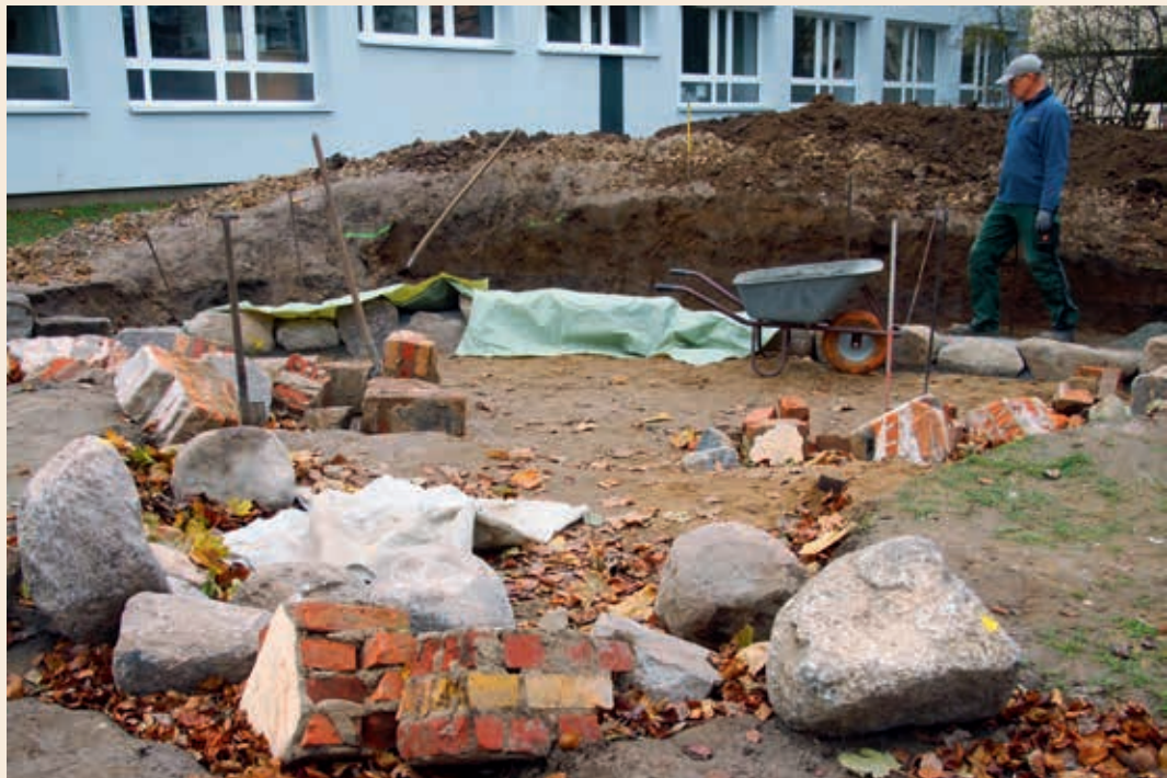
Grünes Klassenzimmer im Bau
